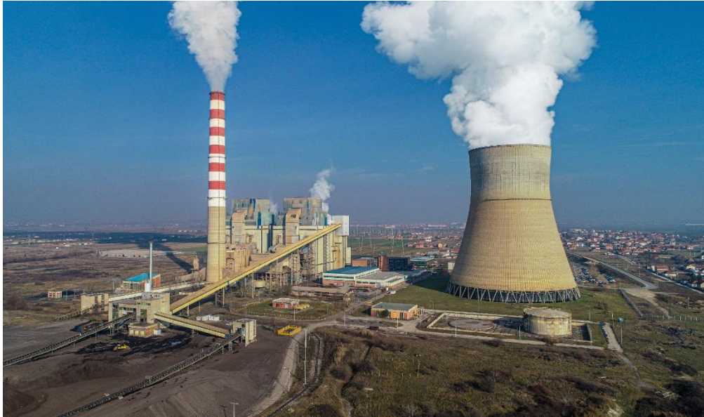
Figura 6-8: Termocentrali elektrik Kosova B
