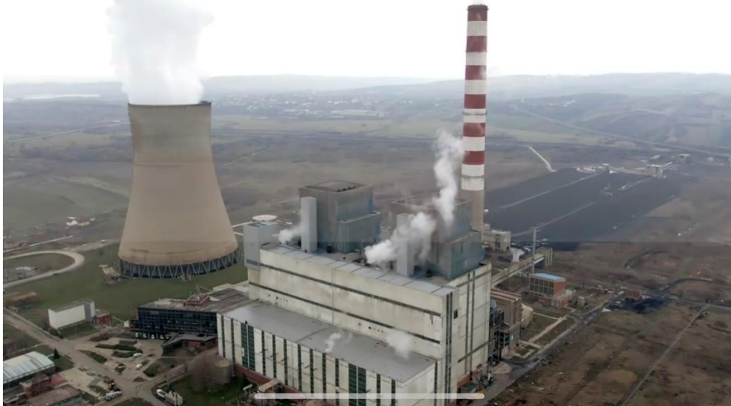
Figura 7-5: Termocentrali elektrik Kosova B
