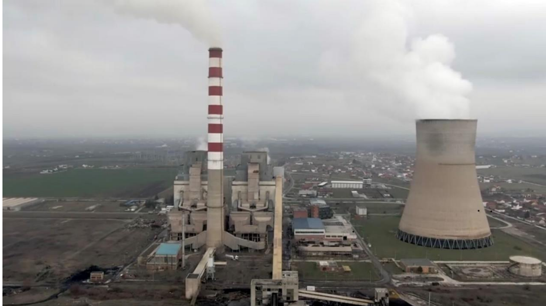
Figura 7-8: Termocentrali elektrik Kosova B
