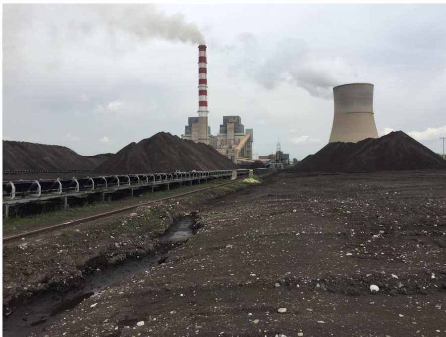
Figura 6-15: Kanali drenazhues në vendndodhjen e qymyrit
