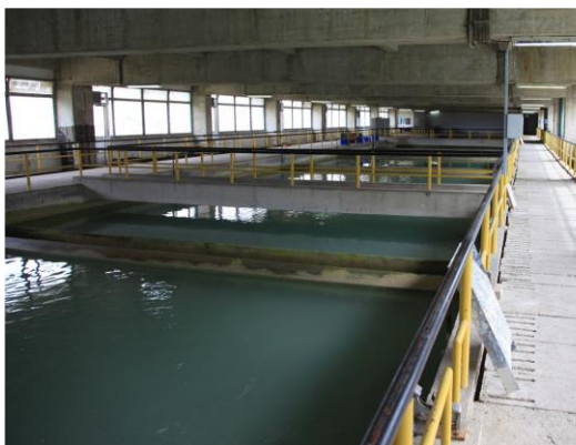
Figura 6-9: Sistemi i dekarbonizimit të impiantit të trajtimit të ujit - filtrat e rërës
