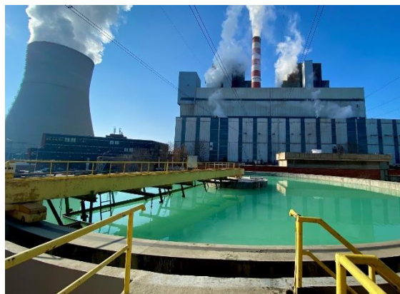
Figura 6-10: Sistemi i dekarbonizimit të impiantit të trajtimit të ujit – klarifikues
