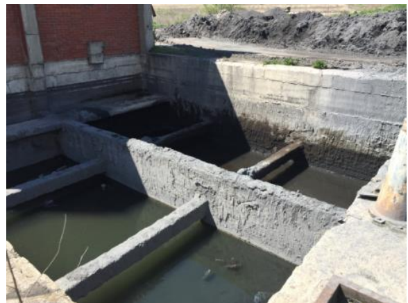
Figura 6-12: Rezervuar dekantim me gravitacion – Sedimentuesi
